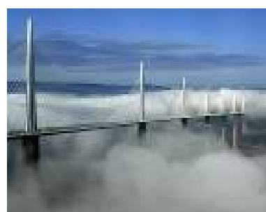
Viaduc de Millau
